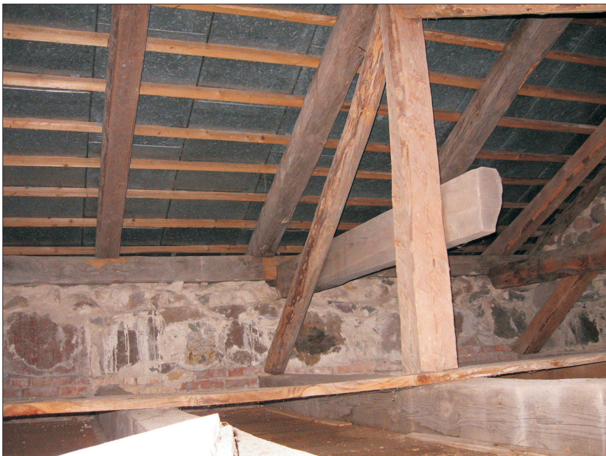
FRAGMENT WIĘZBY DACHU NA STYKU NAWY BOCZNEJ I GŁÓWNEJ.
